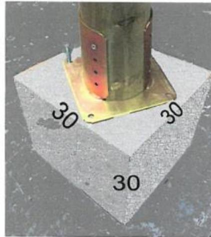
Avec socle: il est nécessaire de creuser un trou avec les bonnes dimensions pour les poteaux principaux. Vérifier le béton dans l'excavation avant de fixer la plaques avec les bouchons.
